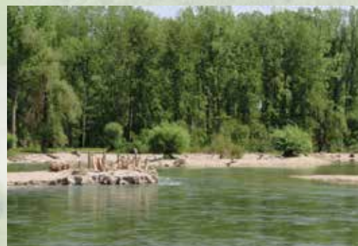
Die Ausleitung in den Nebenarm der Isar ist massiv mit naturnahen Wasserbaumethoden gesichert
