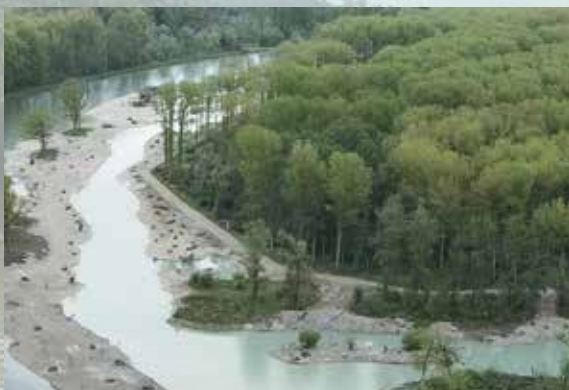
Der Bauabschnitt 2 kurz vor Öffnung des Seitenarms, rechts im Bild die Anbindung des Altwassers „Angergries“
